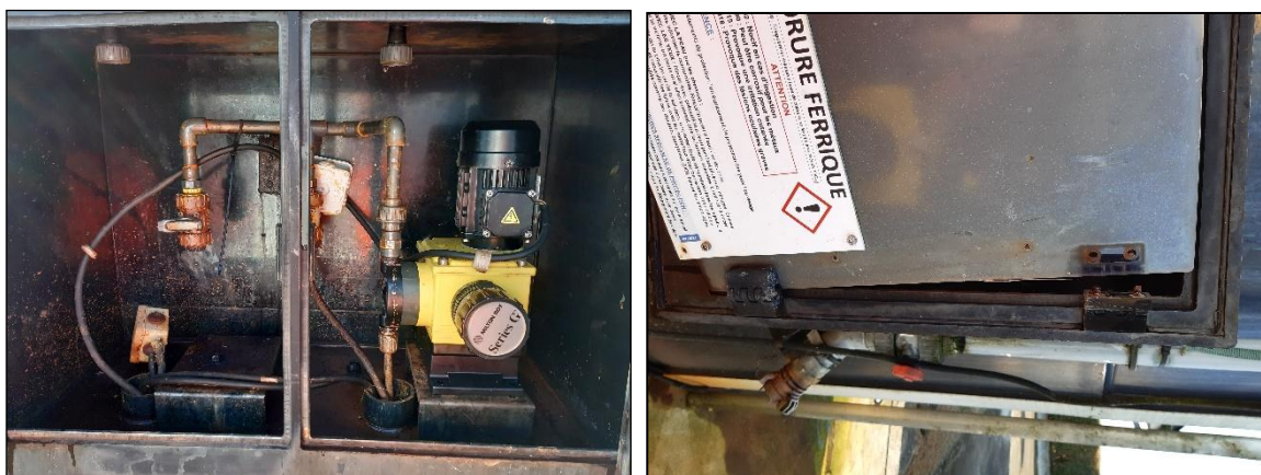
Armoire de la pompe d'injection du chlorure ferrique et cuve de stockage du réactif.
