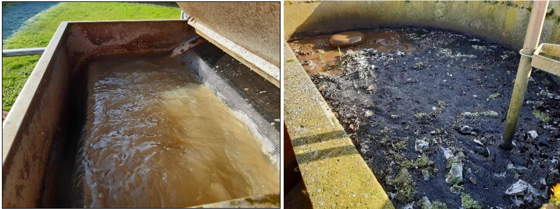
Nettoyer régulièrement le tamis... afin d'éviter les passages au trop-plein interne
