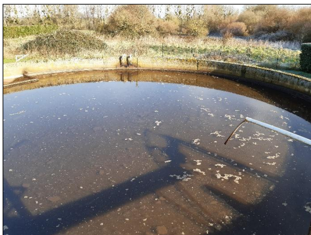
Vue du bassin d'aération - absence de brassage lors des phases de non aération.
